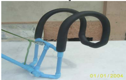
(๗) ติดตั้งเสร็จแล้ว
